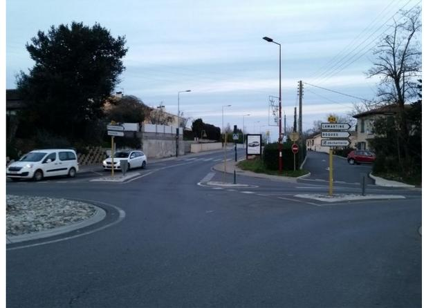
Figure 5: Rond-point réalisé dernièrement sans aménagement cyclable, pourtant l'emprise était suffisante
