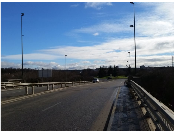
Figure 8: Le pont au dessus de l'autoroute A64
